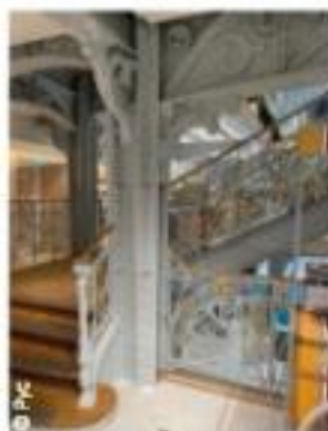
L'escalier et certains poteaux ont été démontés, restaurés puis mis en conformité.
