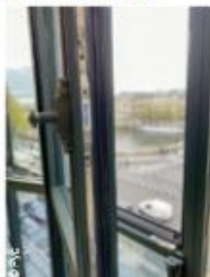
Les châssis acier ont été modifiés par Chauvet pour pouvoir atteindre le niveau d'affaiblissement acoustique exigé.
